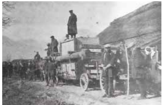
安曇電気 宮城第一発電所 機器輸送風景
