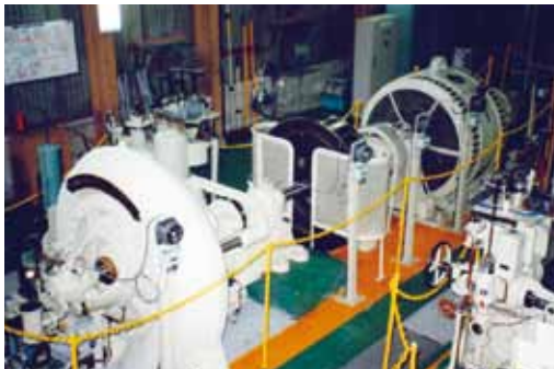
安曇電気 宮城第一発電所 水車発電機
