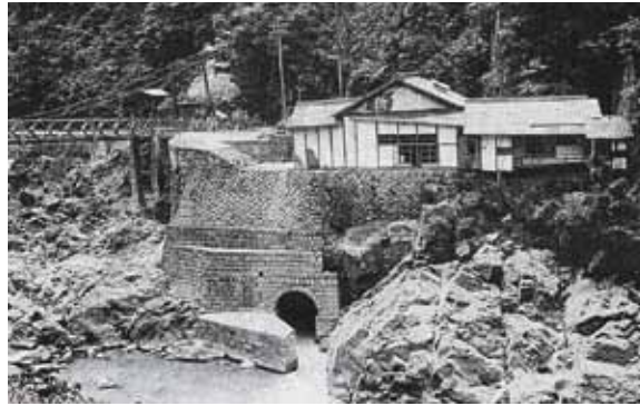
多治見電灯所 土岐川発電所外観(当時)
