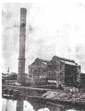
名古屋電灯 熱田火力発電所 外観(当時)
