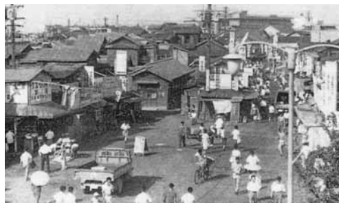
駅から見た当時の駅前。手前側半分が新幹線用地
