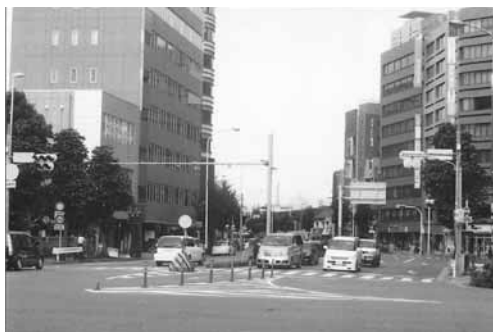
新しく開かれた駅西口広場への幹線道路
