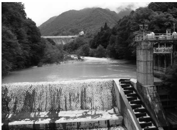
高瀬川第一発電所の堰堤と取水口(手前)奥に写っているのは大町ダム(出典:安倍伸一(Aベ企画))
