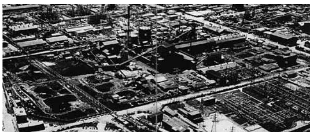
矢作製鉄工場(7号地)
