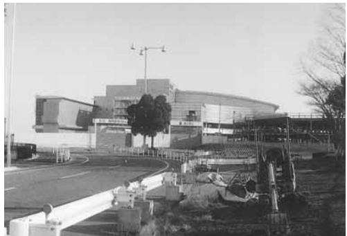
旧国際線ターミナルは改修工事が進んでいた
