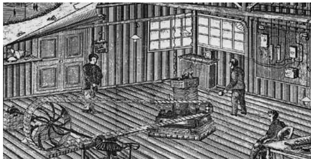
箱根電灯所 湯本発電所内部
