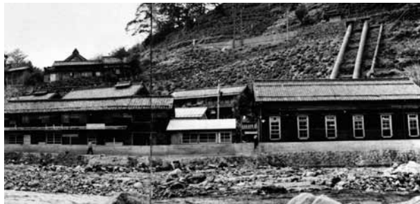
岐阜電気 小宮神発電所
