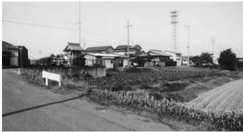
松川付近の河川堤防跡
