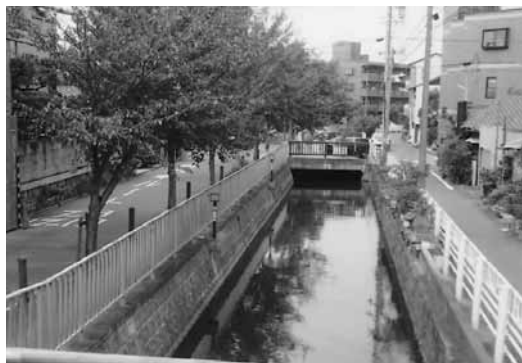
地藏橋近くの庄内用水(左の道が街道)
