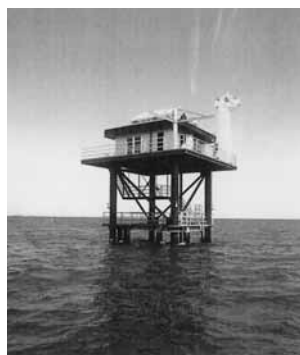
海上環境測定局。常滑港沖3 キロ の空港予定地に設けられた。ここで気象、海象、藻類育成実験がつけられた(文献②)
