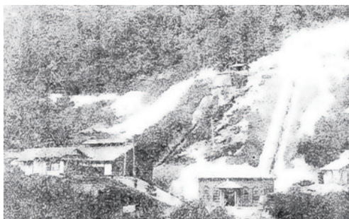
飯田電灯 松川第一発電所第3次増設工事
