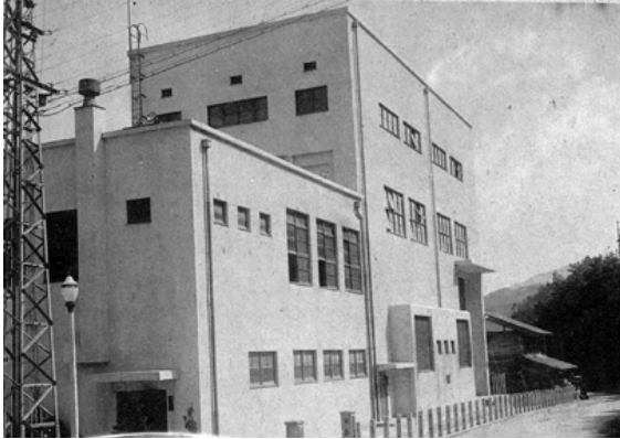
中央電力 生田発電所
