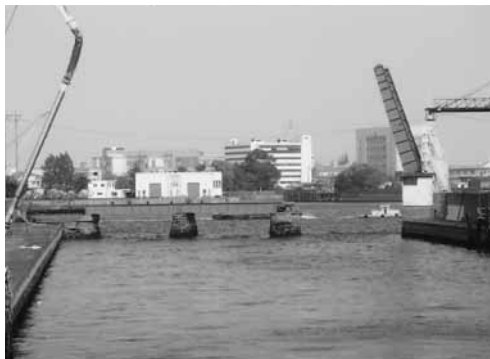
貴重な文化財になった跳上橋
