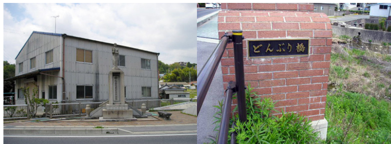
どんぶり橋の近くにある町営電気事業記念塔
