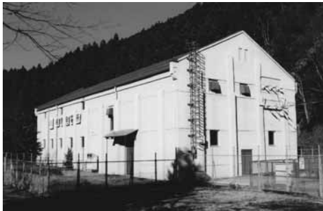
根尾発電所(現況)
