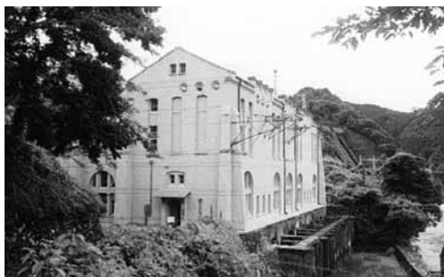
八百津発電所(現況)
