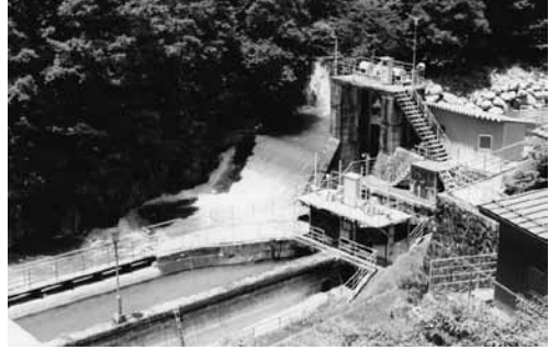
松川第三発電所取水口・沈砂池
