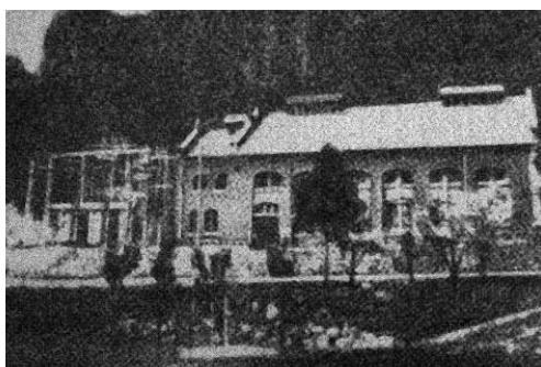
広滝発電所(明治42年ごろ)
