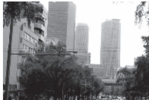
堀川桜橋付近から名古屋駅方向を振り返る
