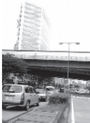
中央分離帯の施設が地下の共同溝の存在を示している
