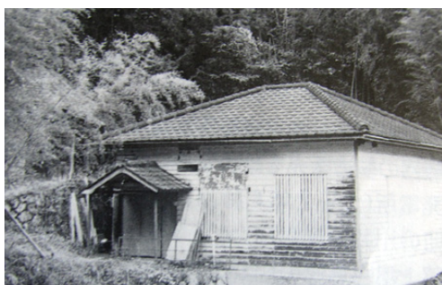
建物が残っている静波(第三)発電所
