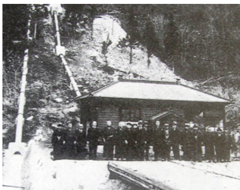
完成時の三濃(第二)発電所
