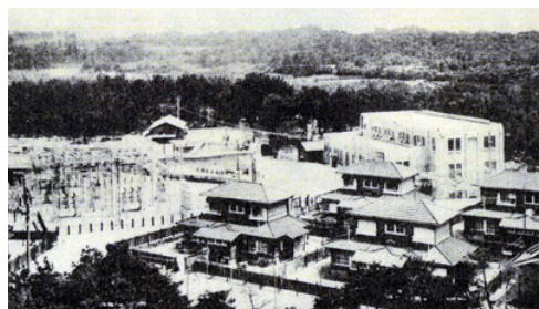
越戸発電所(当時)(『中京名鑑』昭和11年9月)
