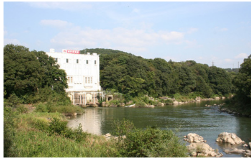
中部電力越戸発電所
