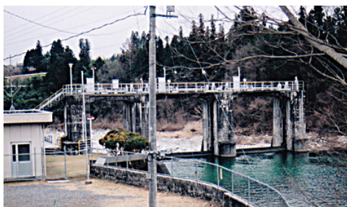
三穂発電所ダム(筆者撮影)
