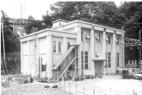
駒場発電所（伊那電気鉄道建設） 『伊那谷電気の夜明け』
