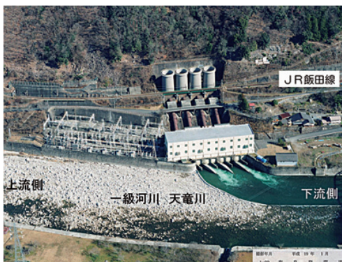
秦阜発電所 (中部電力提供)
