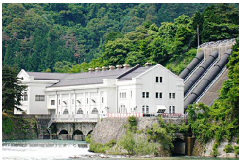
賤母発電所全景
