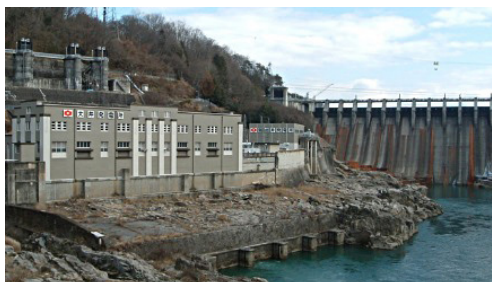
大井発電所全景
