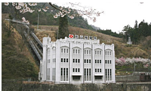
桃山発電所全景
