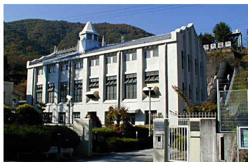
須原発電所全景
