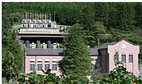
大桑発電所全景
