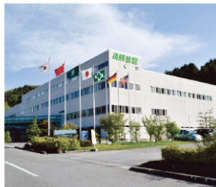
丸子電子機器工場
