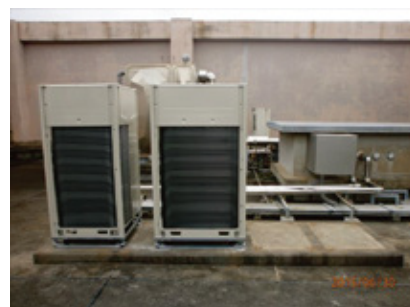
③空調機器の更新
