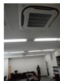
③空調機器の更新
