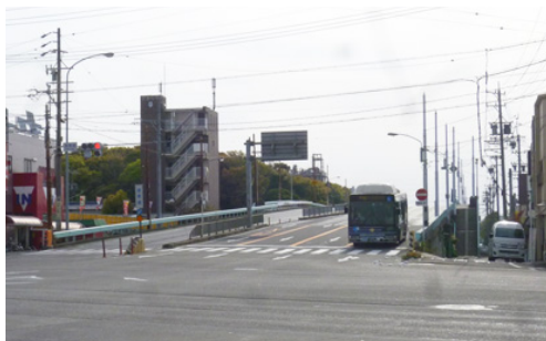
名鉄常滑線の陸橋
