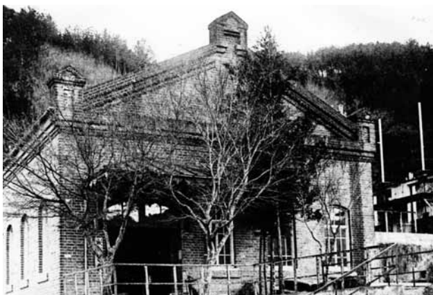
松阪水力電気 鋸形発電所
