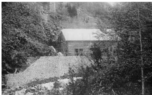
樽川第二発電所建設工事
