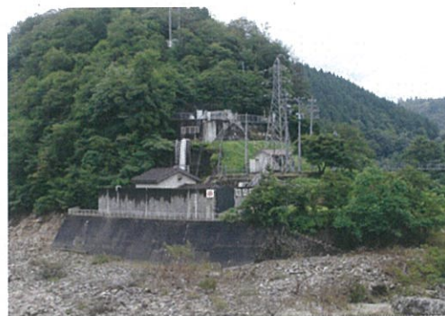
奥戸発電所(中部電力岐阜支店提供)
