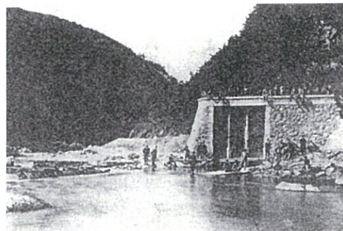
奥戸発電所取水口 (「恵那町史通史編第3巻(1)上」平成5年1月)
