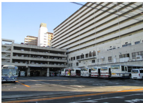
裏側がバスの車庫(営業所)になっている
