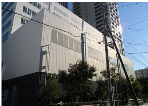
裏側の駐車場棟。
