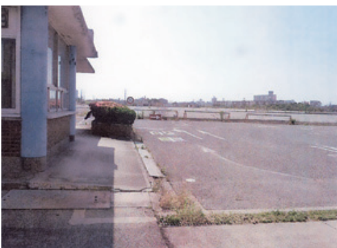
廃止されたガス工場跡。新しい開発に着手した。 平和博のシンボルが欲しいところ
