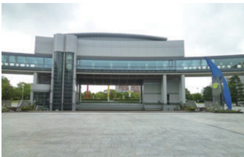
国際会議場は拡張されて、 正面にはレストランがつくられた
