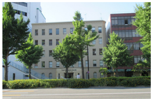
布池町にある大洋商工ビル。 落ち着いたたたずまいを見せている
