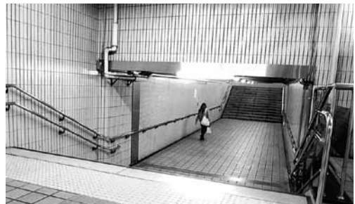
神宮西駅の出入口。 共同溝の下になるため通路が下っている
