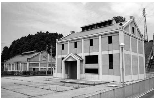
新旧の黒部川第二発電所(出典：水力ドットコム) 旧・黒部川第2発電所(左)：黒部川電力が1926(大正15)年に建設 新・黒東第3発電所(右)：北陸電力が1993(平成5)年に再開発
