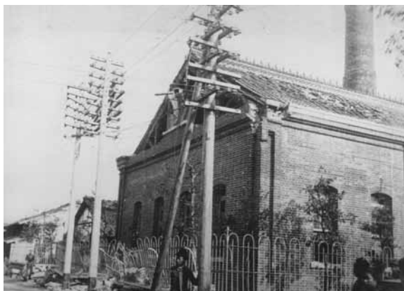
名古屋電灯発電所(濃尾震災直後)
