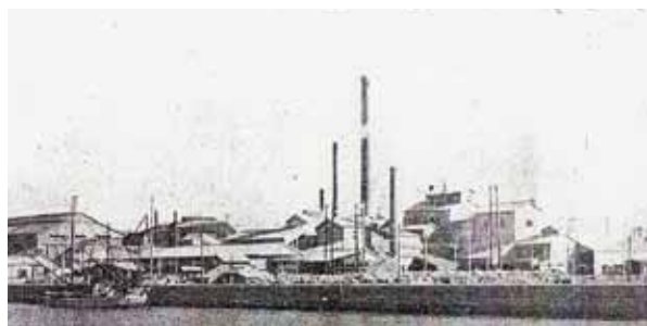
豊国セメント名古屋工場
