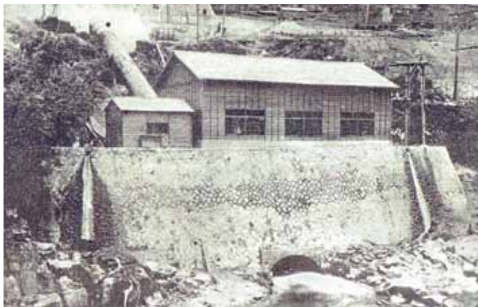
串原仮発電所
