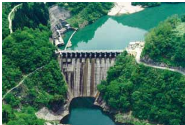
昭和電力祖山ダム(関西電力提供)
