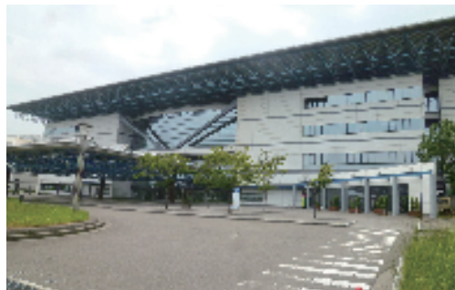
国際展示場(ポートメッセ)の正面。 建物は展示場をつなぐ交流センター
