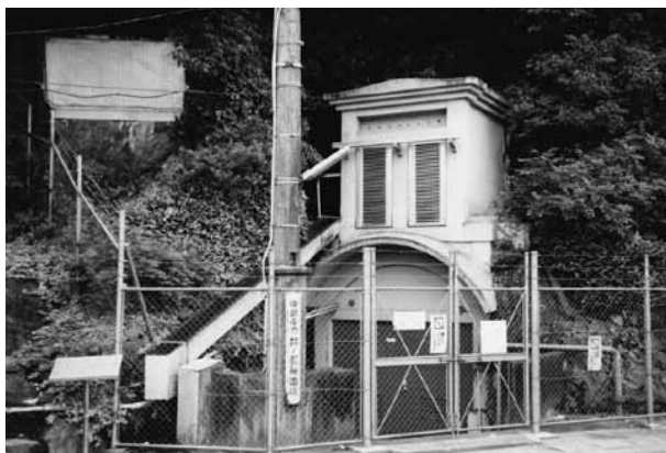
井ノ面発電所外観
