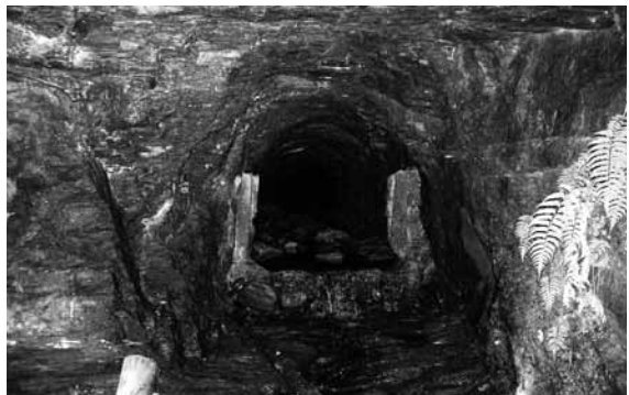
岩を穿って作られた川瀬発電所取水口
