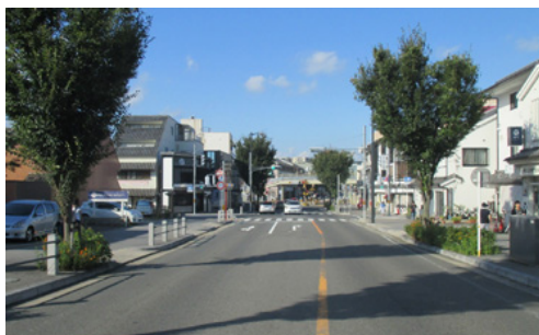
開通した都市計画道路。幅20 メートル
