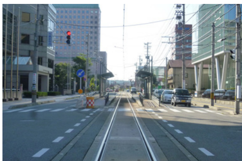
新設の軌道部に作られた停留場。 左側乗降のため、両側にホームがある
