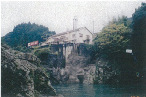
長篠発電所外観
