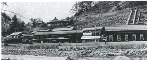
岐阜電気小宮神発電所
