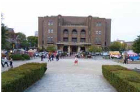
土地博の会場は工事中の公会堂の手前につくられた。 噴水の反対側が御大典博の本門になる
