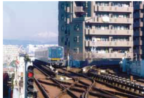
右手に車庫引込線。正面は御岳に向かって止っている
