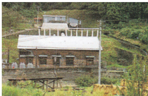
下切発電所外観(改修前)
