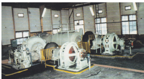
下切発電所内部装置(改修前)
