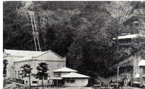
塔ノ沢発電所 『関東の電気事業と東京電力』 平成14年3月
