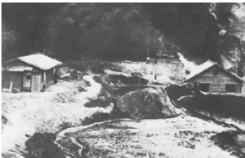
長野電灯 茂菅発電所 『長野に電気が点いて八十年』 中部電力長野営業所
