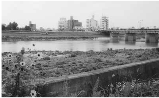
昔の橋の付近から現在の枇杷島橋を
