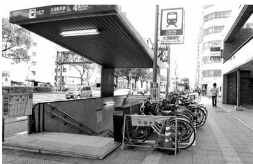
大須観音駅付近。 地下鉄出入口は自転車が歩道を埋めている
