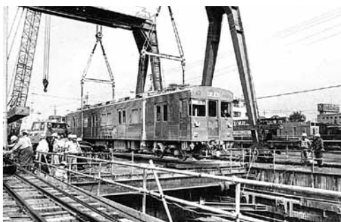
図4 道路から吊り下げて搬入される鶴舞線車両。 36両が入られた(名古屋市交通局提供)
