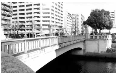
新堀川の記念橋。 外側だけ、旧状のアーチ形にもどされている
