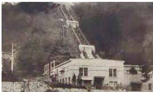
矢作水力 下村発電所
