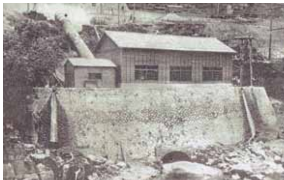
串原仮発電所
