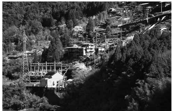
中部電力・西渡発電所全景(出典：水力ドットコム)
